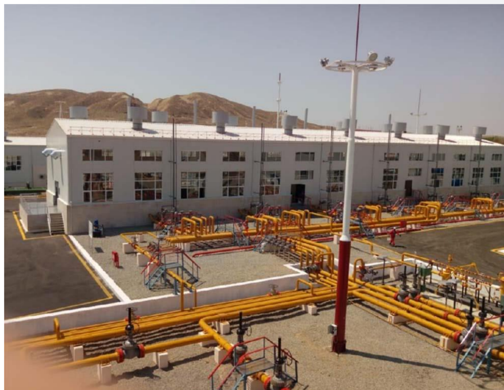
Внешний вид компрессорного цеха МКС12 Карадагского СПХГ (SOCAR)
