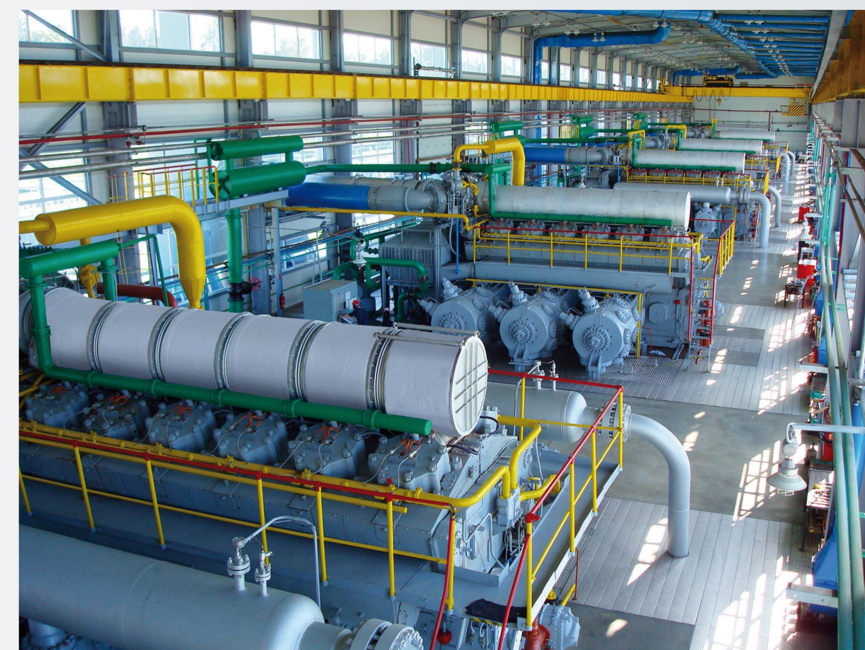
Вид компрессорного цеха МКС12 Карадагского СПХГ (SOCAR)
